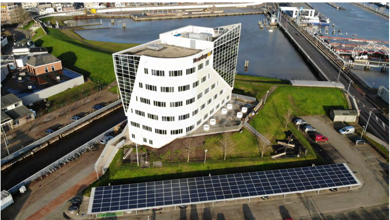
Zonnepanelen in Delfzijl, locatie Duurswoldlaan
